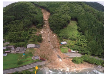
土砂災害現場
